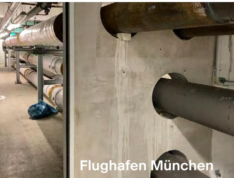
Die Verlegung von 4.000 Metern KMR-Rohren im Erdbereich und 3.360 Metern im Versorgungstunnel, die Durchführung von circa 40 Tonnen Stahlbau und circa 2.000 Schweißnähten an den Rohrleitungen sind nur einige Eckdaten aus diesem Projekt. In Spitzenzeiten arbeiteten bis zu 30 JR Mitarbeiter am Neubau der Fernwärme- und Fernkälteleitung am Flughafen München. Eigentlich ein Routineprojekt, wären da nicht die Arbeiten im Sicherheitsbereich. Hierfür mussten sich
