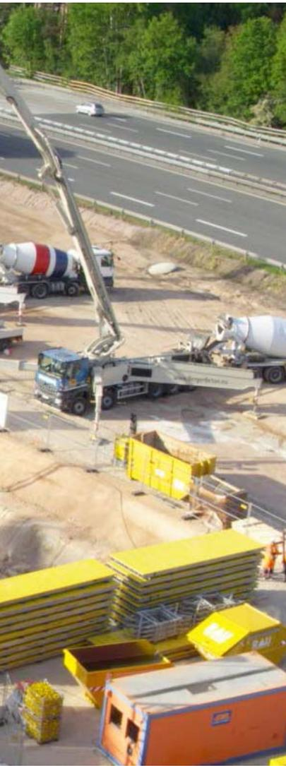
Trotz enormen Zeitdrucks lief bei beiden Vorhaben alles nach Plan. Beim Abbruch des Überbaus der Behelfsbrücke musste erst die Betonfahrbahn abgebrochen werden, bevor die 20 Stahlträger mit einer Höhe von einem Meter und einer Spannweite von 29 Metern heruntergehoben werden konnten. Anschließend wurde der Abbruch des massiven Mittelpfeilers durchgeführt.
