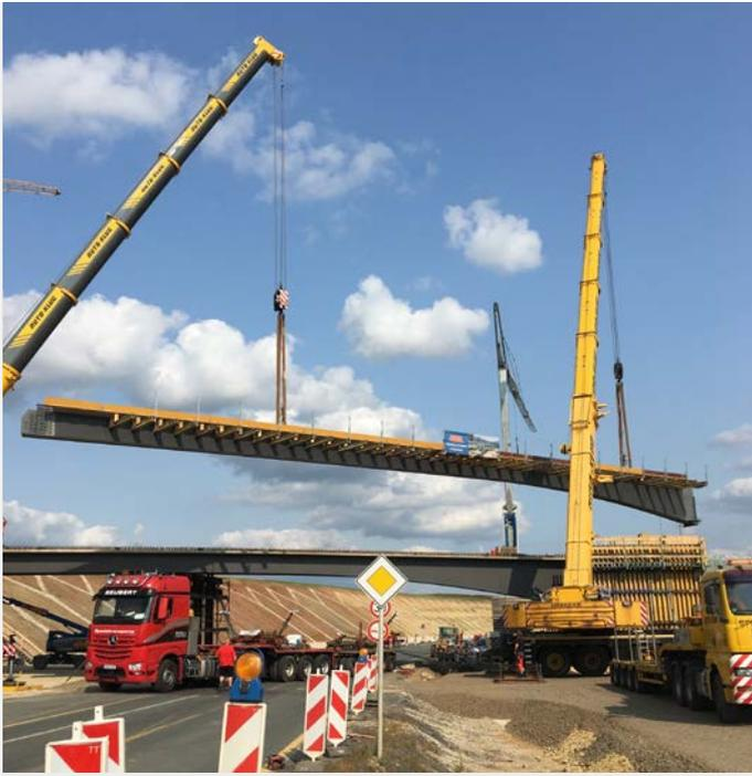
Ganz schön in sich hatte es der Trägereinhub für die Verbindungsbrücke Hohenberg an der Eger und Schirnding. Als Tandemeinhub mit zwei Autokränen wurden insgesamt sechs Stahlverbundträger mit einer Länge von je 45 Metern und je 70 Tonnen Gewicht eingehoben. Eine schwere Angelegenheit!
